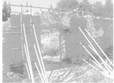
Εικ.10. Ι.Μ. Αγίας Παρασκευής Ταφίου. Η υποστύλωση της πύλης. Εσωτερική όψη. (Αρχείο ΕΦ.Α. ΚΕΦ.)
